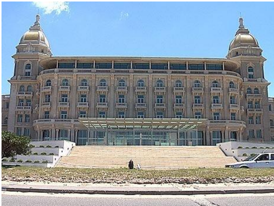
Hotel Casino de Carrasco - 780 HP de Capacidad
