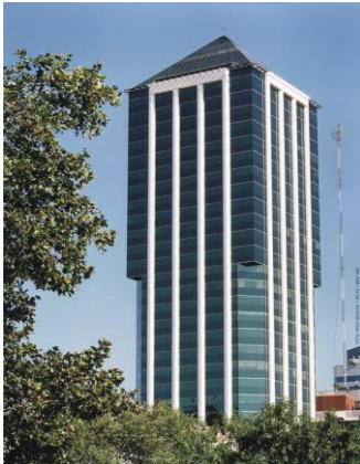
Torre Bouchard - 800 tr de Capacidad
