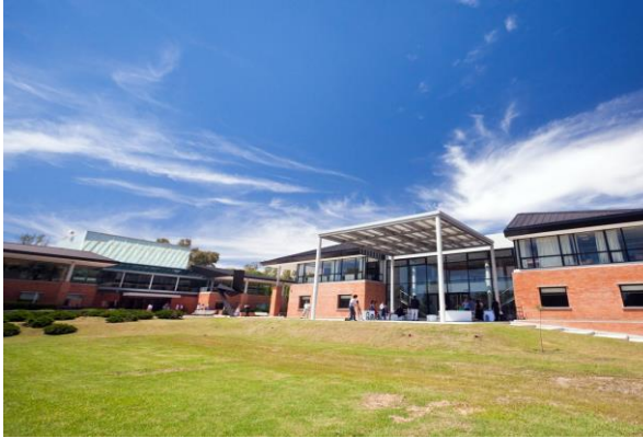
Universidad de San Andres VRV 94HP Oficinas y aulas
