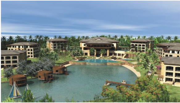
Hotel Sofitel "La Reserva" - 1250 Tr de Capacidad
