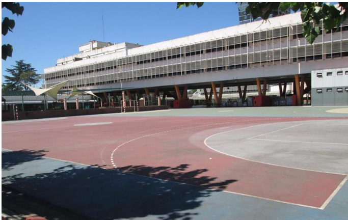
Liceo Franco Argentino Jean Mermoz Edificio Secundaria y Auditorio
