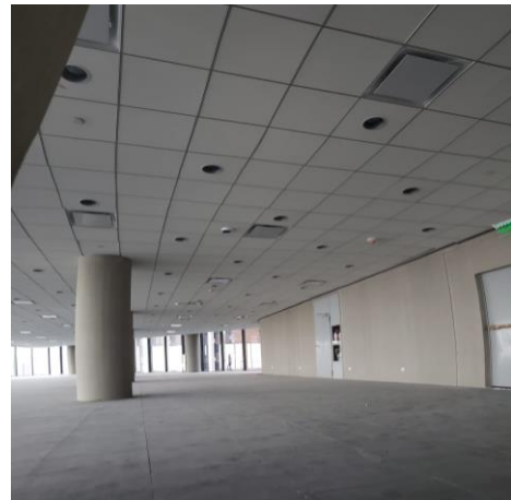
Mercado Libre edificio Polo Dot Sistema VRF heat Recovery
