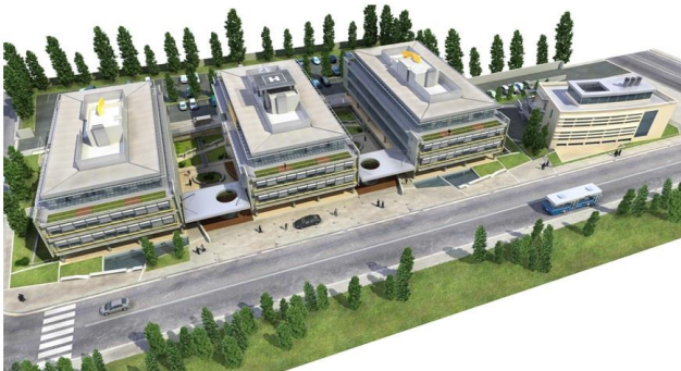
Bureau Parc San Isidro VRV 582HP- En Construcción-
